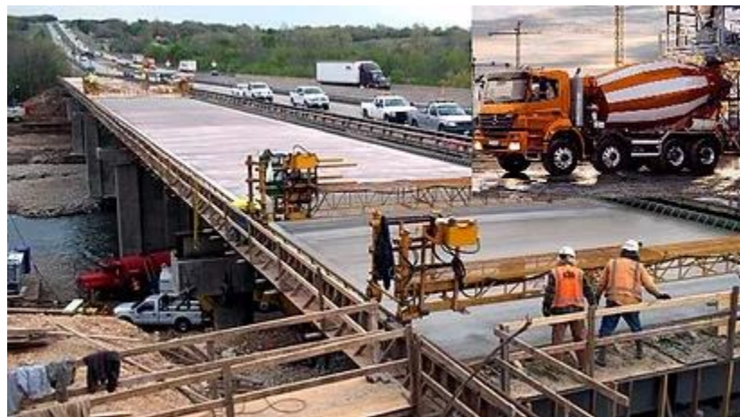
Мостовые бетоны (в солях) B25 F 2300 W10 -B45 F 2300 W16
